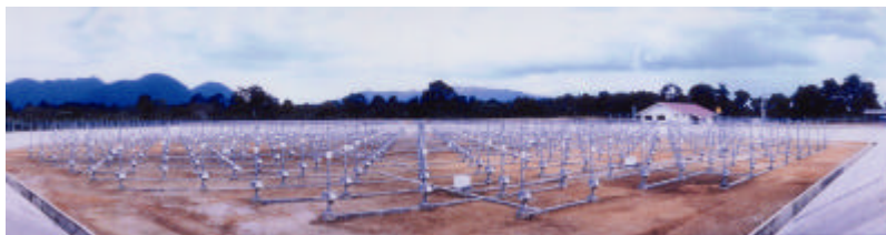
Antenna (diameter 110 m)
